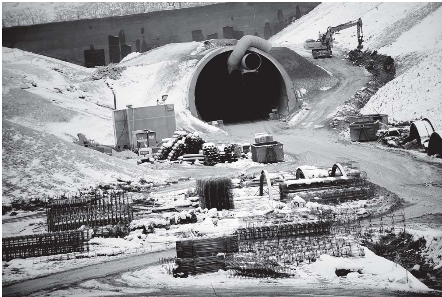
Le chantier de construction du tunnel « Chavanne » dans le Doubs sur la ligne à grande vitesse qui reliera l'Alsace au Lyonnais. Les infrastructures ferroviaires représentent 300 millions d'euros dans le plan de relance français. JEFF PACHOUD/AFP
